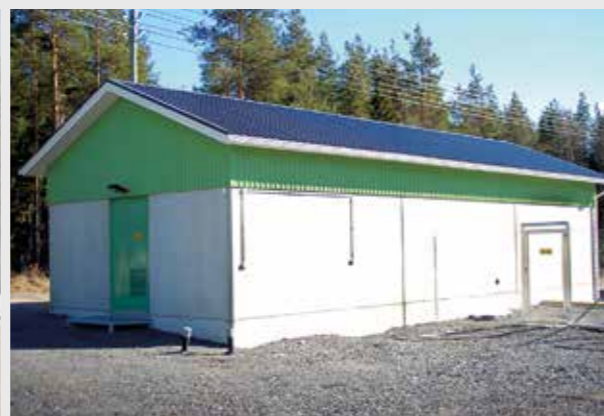
Skyddsrum i betongkonstruktion med brandklass Br1
