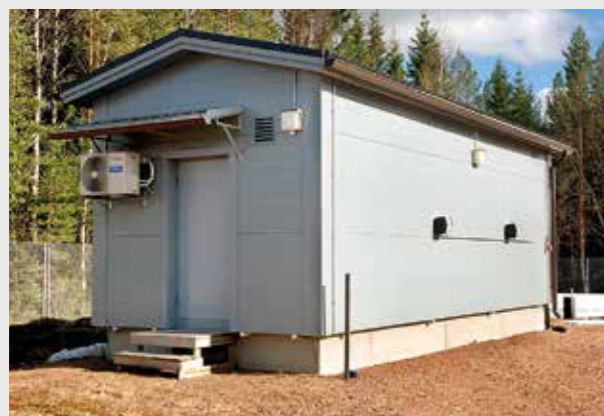
Skyddsrum i stålkonstruktion med brandklass Br2
