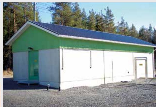
Betonirunkoinen P1 paloluokan laitetila.
