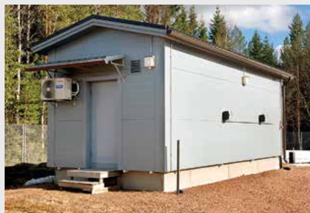
Teräsrunkoinen P2 paloluokan laitetila.
