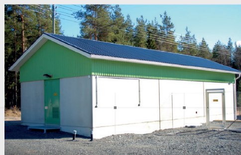
Betonirunkoinen P1-paloluokan laittila.
