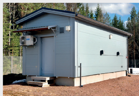
Teräsrunkoinen P2-paloluokan laittila.
