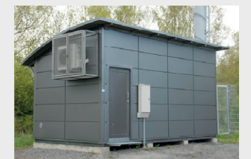
Millennium Maxi peltikasettiverhouksella
